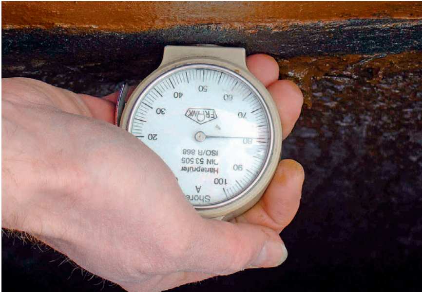
Abbildung 4: Messung der Shore-Härte des Mörtels direkt am Objekt
