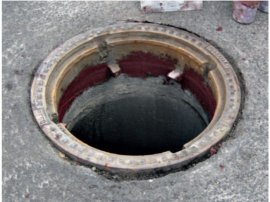
Abbildung 2: Sanierte Schachtfuge mit dem eingebauten rot pigmentierten Kunststoffmörtel
