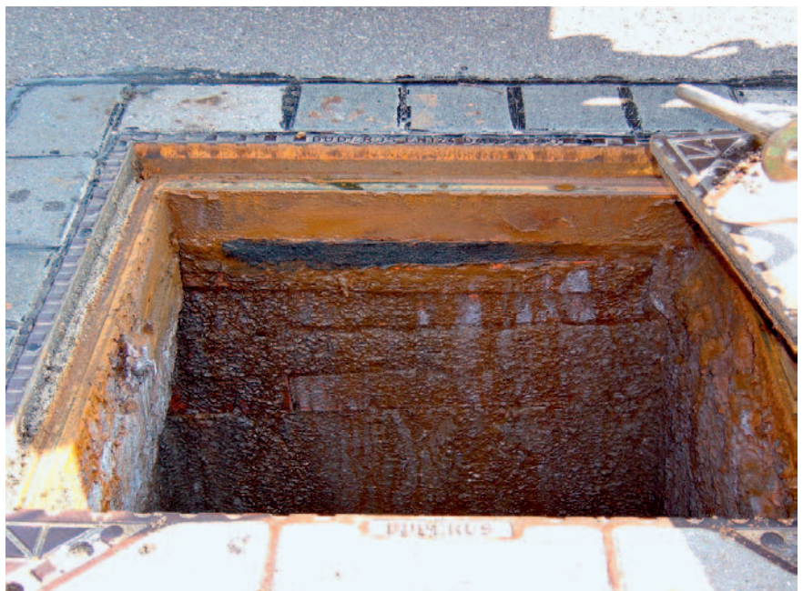
Abbildung 3: Freigelegte Fuge der Abdeckung im Freimersdorfer Weg in Köln
